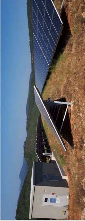
Exemple de support fixe (Source : Audifcé environnement)
